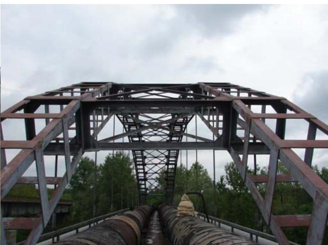
Structura de rezistenta este alcatauita din doua arce metalice paralele avand lungimea de 67,00m care sustin prin intermediul tirantilor, un tablier metalic care sustine patru conducte de aductiune a apei din sursa Timisesti. Positia intermedia a tablierului metalic determina modul de alcatura a structurii de rezistenta si denumirea sistemului de constructie.
